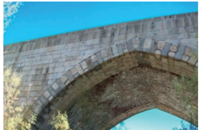
(d) Brick filling material inside the arch
